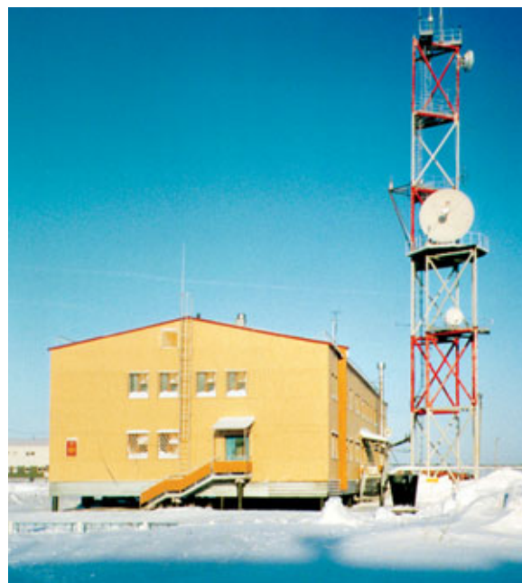
▲ Первая земная станция спутниковой связи ОАО «Газком», п. Ямбург
